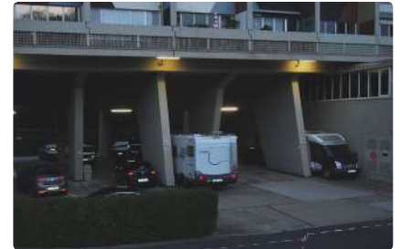
Húsið stendur á vegghlutum til að leyfa náttúrunni að flæða undir. Nú bílastæði
