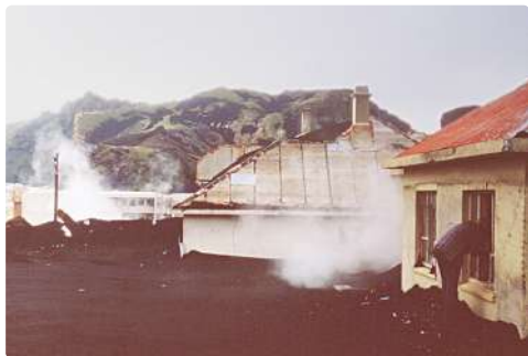
Heimaeyjargosið sýndi hve gjóskufall er hættulegt fyrir byggð. Gjóskan kveikti í og sligaði þök
